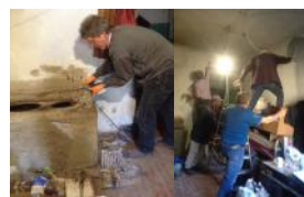
Repareren van de stoof, sauzen en schilderen
