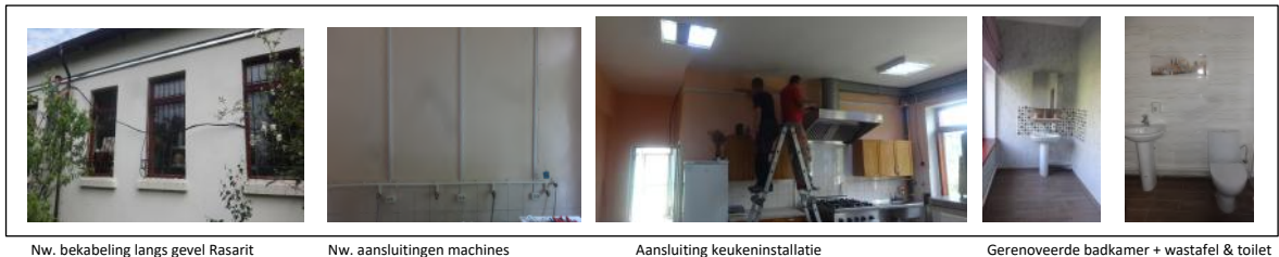
Nw. bekabeling langs gevel Rasarit
